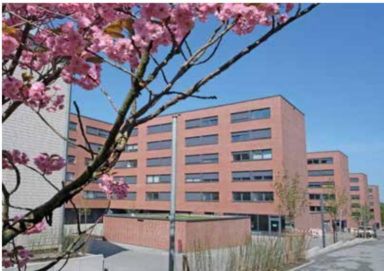
Blockheizkraftwerk, das allen drei Wohnanlagen am Kastanienweg Heizwärme, Warmwasser und Strom zum Eigenverbrauch zur Verfügung stellt. Die besonders kurze Bauzeit wurde durch standardisierte Wohnungsraaster und industriell vorgefertigte Wände mit Fertigbädern ermöglicht.
